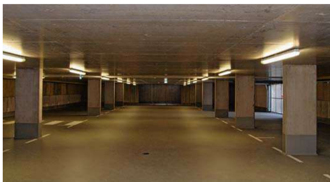
Die zentrale Tiefgarage hat 31 Stellplätze. Von hier aus ist mit dem Aufzug jede Etage bequem erreichbar. Sie ist mit einer speziellen Beschichtung versehen.
