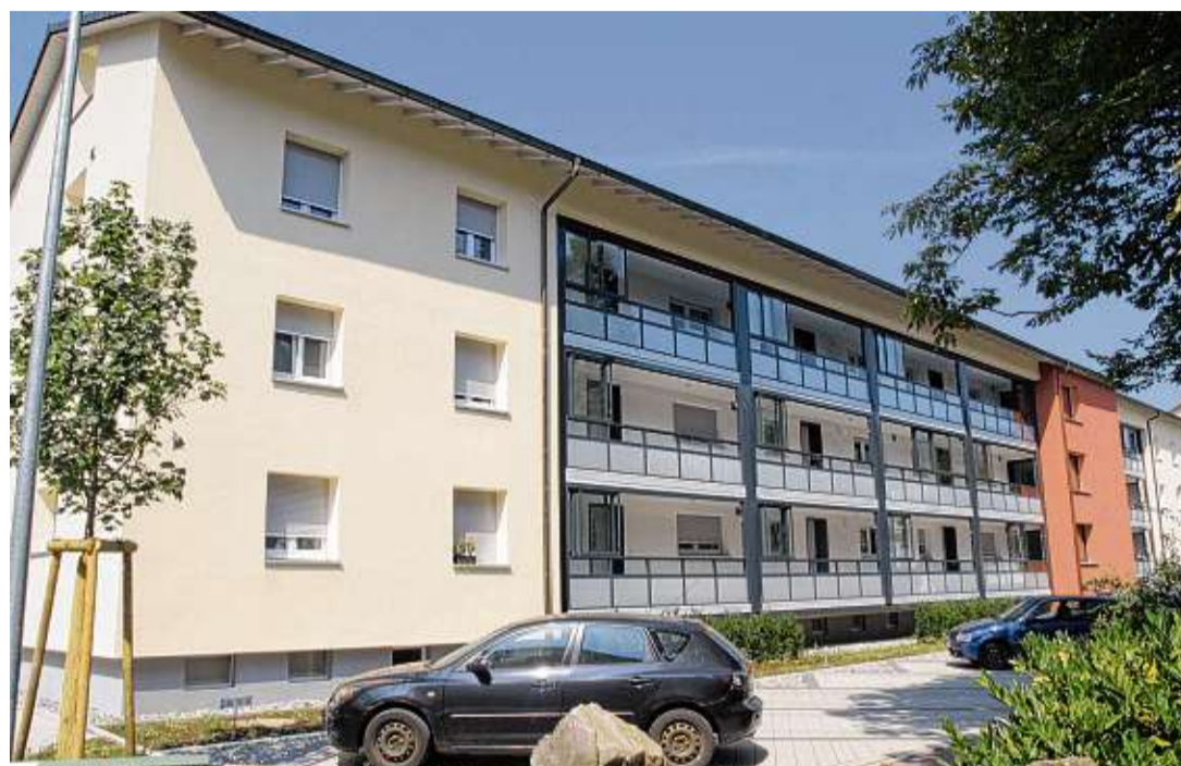
Für 1,9 Millionen Euro wurde der Wohnblock der Baugenossenschaft Föfa Waldshut-Tiengen in der Schlesierstraße 8 in der Tiengerer Südstadt modernisiert.
